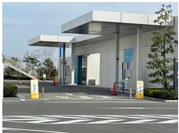
水素ステーション
