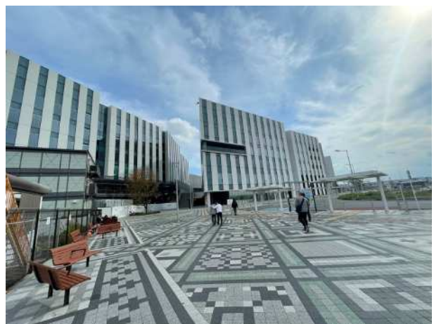
羽田イノベーションシティ外観
