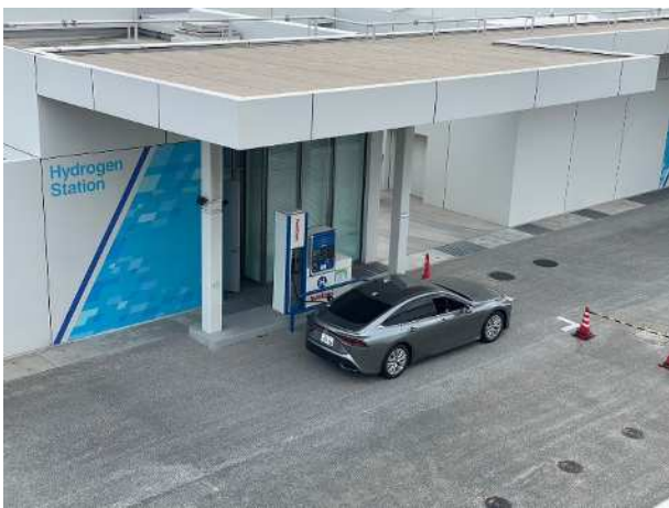
水素ステーション
