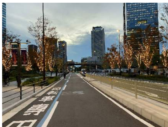
道路舗装のグレードアップ
