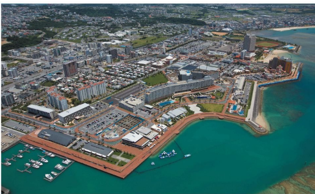
フィッシャリーナ地区 (写真提供: 北谷町)
